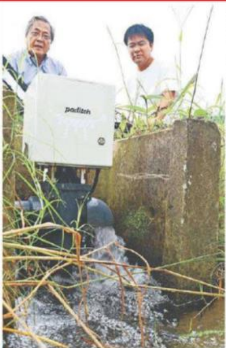
実証実験を行っている水田に水を張る給水栓自動開閉装置＝美馬市脇町別所
